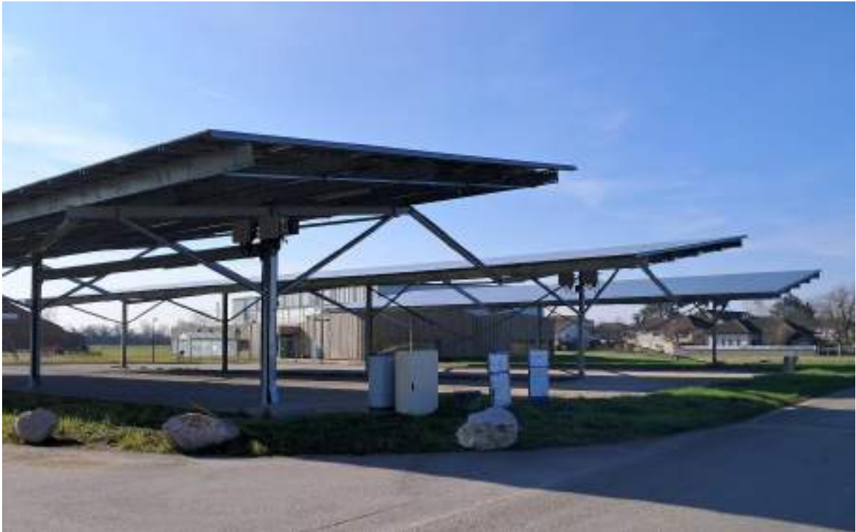
Figure 1 : Ombrières installées sur le parking du gymnase Ernest-Gagnoux à Saint-Aubin.
